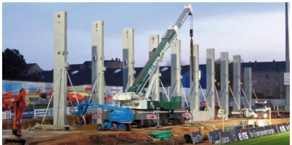
Frühmorgens begann am 11. November die Montage der Stützen der Osttribüne. Als erster Fotograf von vier war Eckart Roßberg der Presseinladung zur Baustelle des CFC-Stadions gefolgt. Mit Kran wurden die angelieferten Stützen in die vorbereiteten Fundamente montiert. An der Westtribüne wird das Dach weiter abgetragen, so dass das Dach im Dezember planmäßig abgetragen sein wird. Nord- und Südtribüne sind im Betrieb. Zeitlich und finanziell liegt der Bau im Rahmen, wie die Stadt mitteilte.
