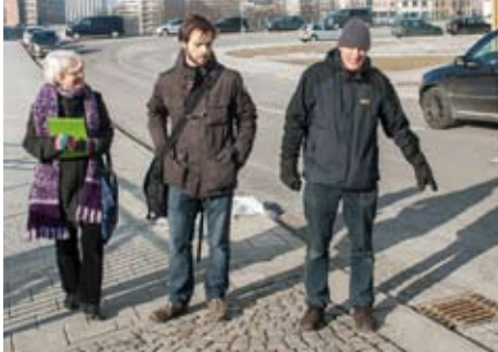
Der Gulli hier ist direkt an der abgesenkten Stelle, schlecht für Rolli- und Rollatorräder.
