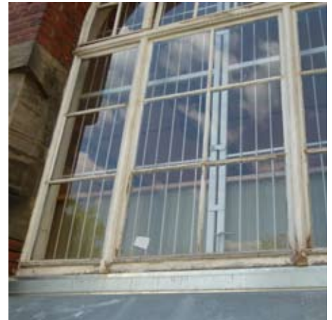
Die Fenster der Sporthalle der Lessingschule. Eine Erneuerung wird auch Heizenergie einsparen.
