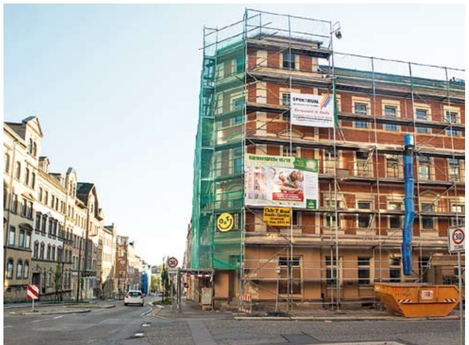
Eine der vielen Baustellen, das Eckhaus Körnerstraße Zietenstraße. Gerade sanierte Eckhäuser erfreuen nicht nur die Bewohner, sondern auch alle Passanten.
