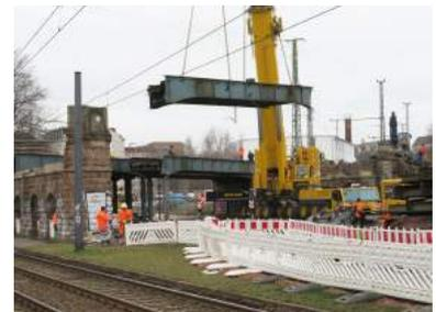
Die ersten Brückenträger an der Ostbrücke werden demontiert
