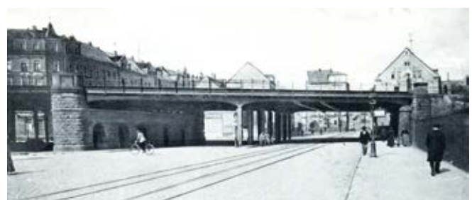
Die sechsgleisige Stahlbrücke von 1909. (Foto: AG Sonnenberg-Geschichte)
