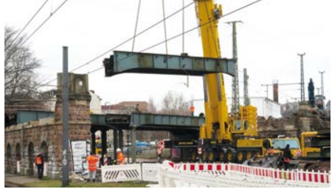
Demontage der Stahlträger - 06.02.2020
