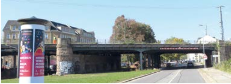
Die Stahlträgerbrücke vor dem Abriss - 07.10.2019 (Fotos: Eckart Roßberg)
