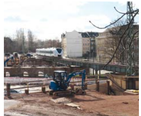
Nach der Demontage der Gleise und Träger - 02.03.2020
