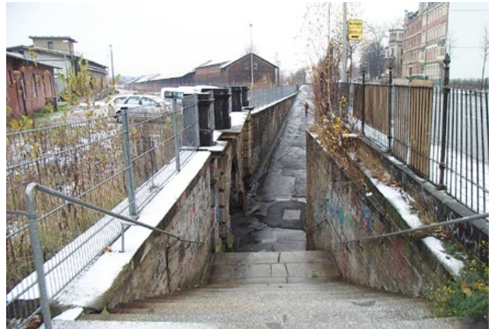
Der Zugang zur Bazillenröhre 2008. Foto: Eckart Roßberg
